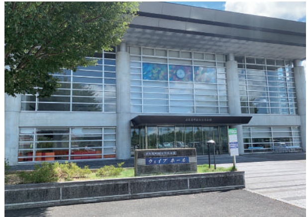
図書館を主として大規模改修予定の総合文化会館
