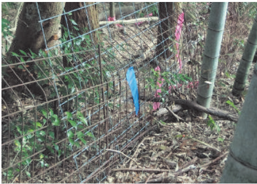
更新を待てない防護柵(補強箇所)
