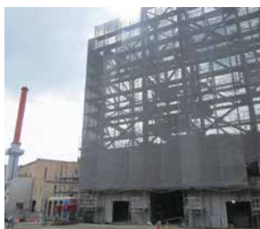
建替え中の東彼保健福祉組合 清掃工場
