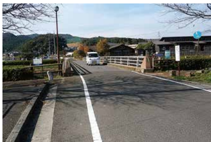
安全対策が必要な西前寺橋
