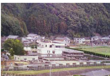
湯無田浄水場
