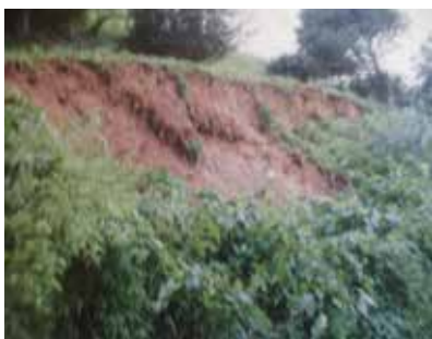
土砂崩れの災害状況
