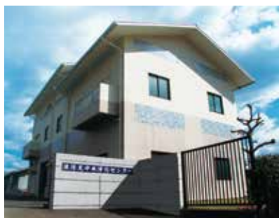
波佐見中央浄化センター
