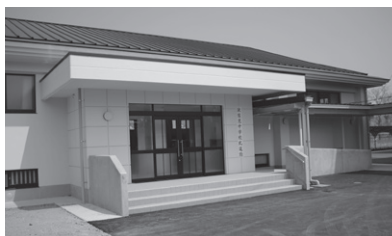
波佐見中学校武道館建替工事
