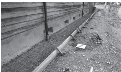
旧中央小講堂兼公会堂耐震補強修復工事
