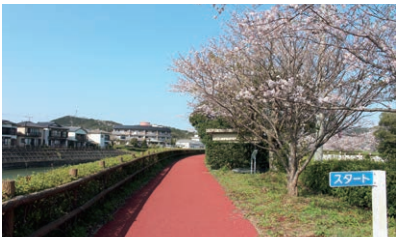
桜づつみ河川公園改修事業
