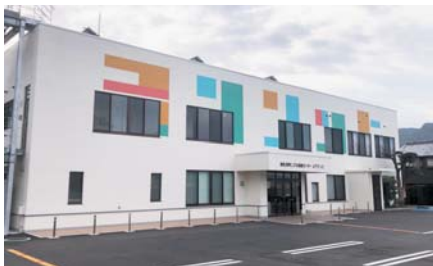
新庁舎建設事業 3億9770万円 ※写真は役場別館「よりそっと」のみ掲載
