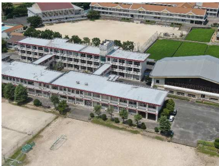
屋上防水：校舎 爆裂
