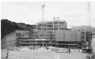
▲建設の様子（平成29年3月現在）
