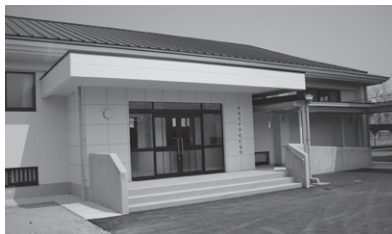
波佐見中学校武道館建替工事
