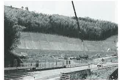
建設中の東彼地区環境センター(平成13年3月完成予定)
