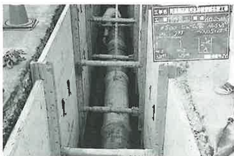
汚水管布設工事状況
