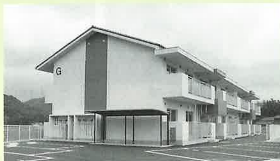
▲建替が完成した山崎団地G棟
