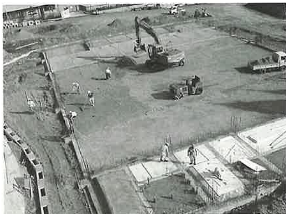
建設中の南小学校体育館
