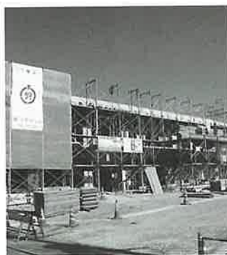
▲建替工事が進む町営住宅山崎団地
