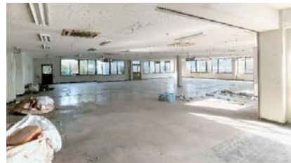
▲解体状況（1 階内部）
