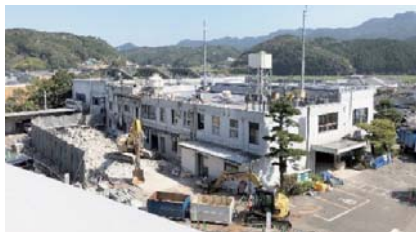
▲解体中全景（令和 6 年 4 月 1 日）
