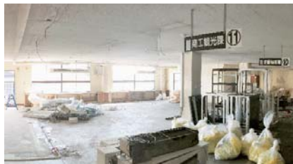
▲解体状況（2 階内部）
