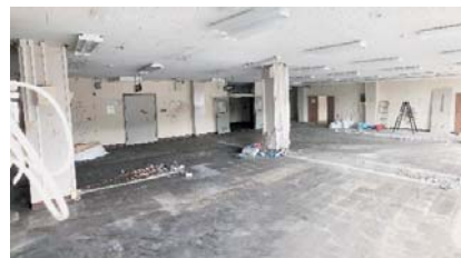
▲解体状況（2 階内部）
