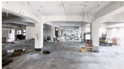
▲解体状況（1 階内部）
