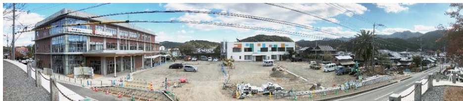
▼鹿山神社側歩道整備工事
