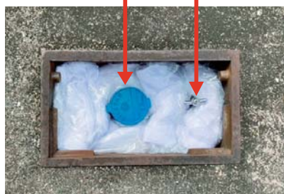
写真Ⅰ メーター器 止水栓
