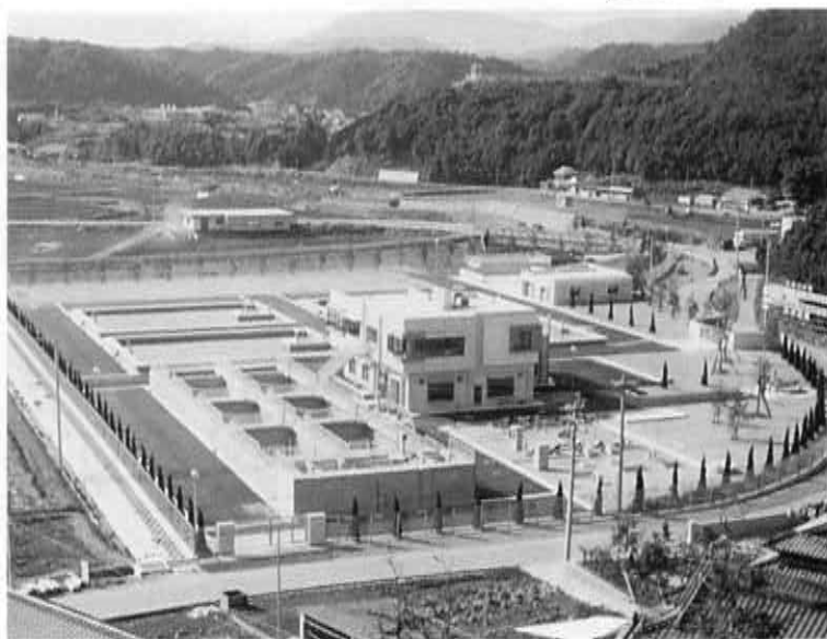
本町上水道の要「湯無田浄水場」 1日5,000トンの給水能力があります。
