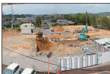
建設位置を床掘開始、着工
