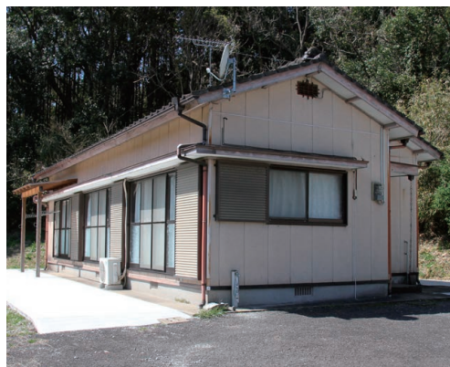
▲お試し住宅の外観
