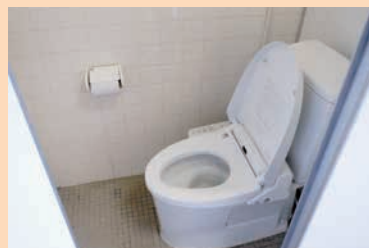
▲改修工事後の洋式トイレ
