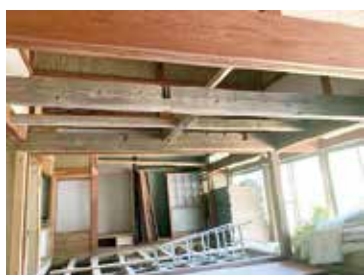
▲ロフト床梁の組みあがり
