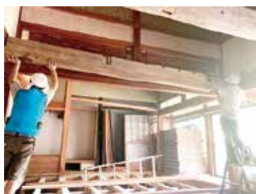
▲ロフトの床梁の仕込み状況
