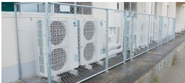
▲児童・生徒の安全対策として室外機周辺にフェンスを設置
