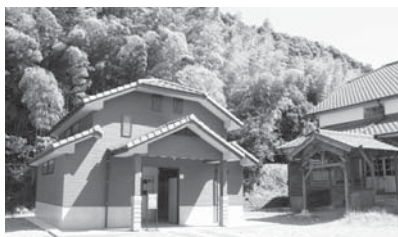
西ノ原公衆トイレ新築工事（講堂横）
