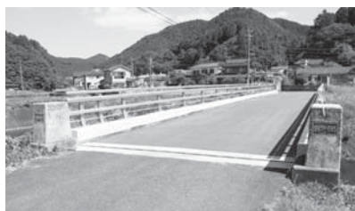
鶴の川橋（湯無田郷）修繕工事
