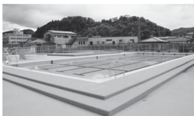
東小学校プール改修工事
